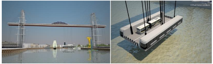
Figure 1 : projet de pont transbordeur à Nantes
