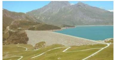
Le barrage est constitué d'une conduite forcée. La hauteur de la chute d'eau est de 880 m et un débit de 50  $\text{m}^3 \cdot \text{s}^{-1}$ .
